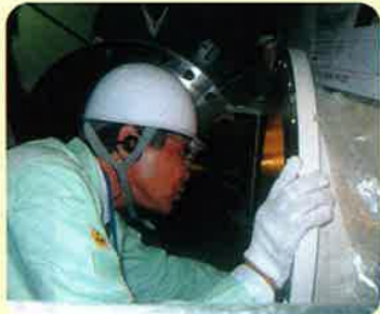
9月10日 東電柏刈原発 完成前の フェルターベント
