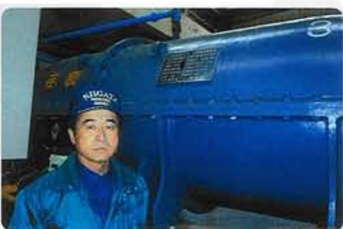
11/30 西川の用水確保の為に巻地区中間補給施設の現況視察
