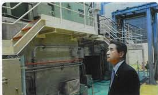
10/27 岩手県の東北電力の日本最大級の地熱発電所を視察
